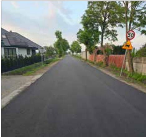
Przebudowa drogi w Biskupicach
