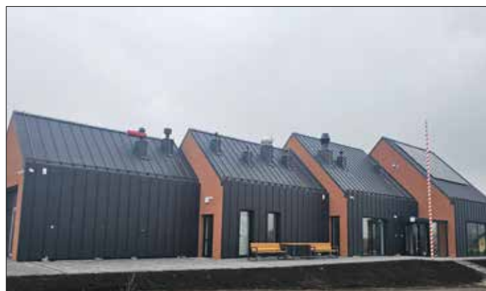
Nowy budynek Remizy OSP w Kozjatach
