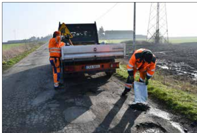
Drogowcy podczas remontu drogi w miejscowości Pruchnowo
