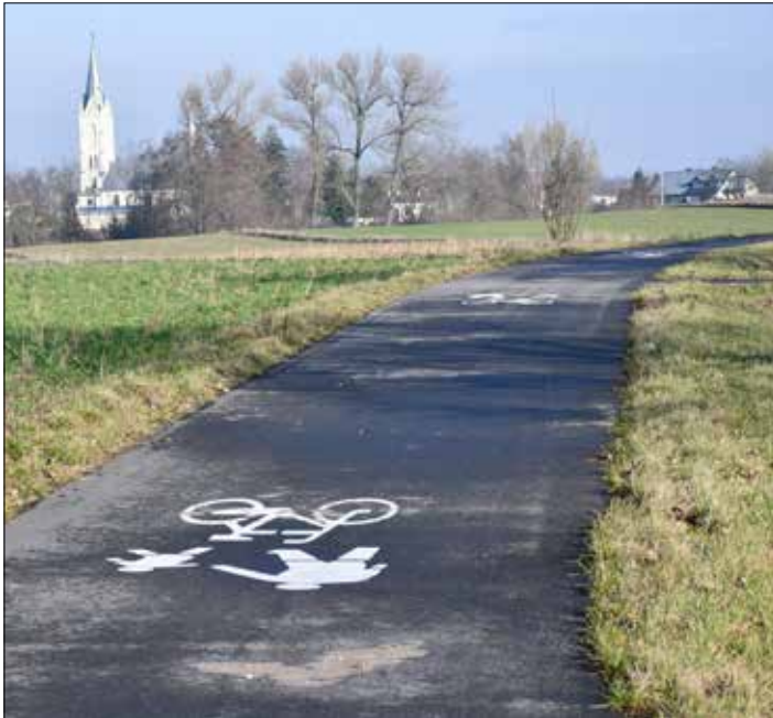
Ścieżka rowerowa w ciągu drogi powiatowej Piotrków Kujawski-Przewóz
