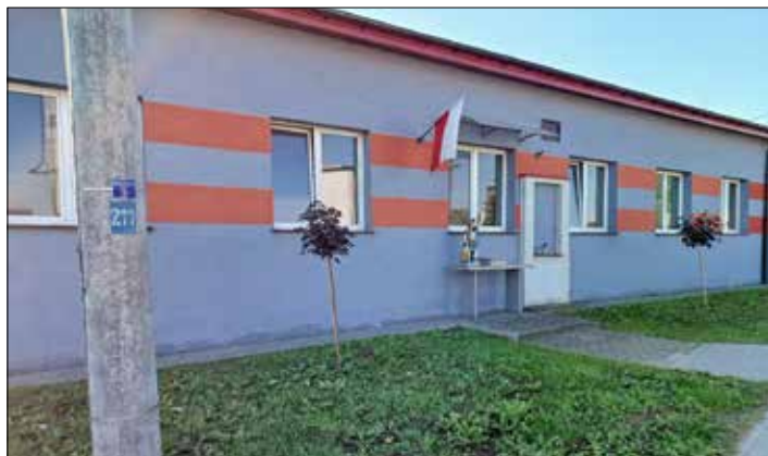
Elewacja zewnętrzna budynku
