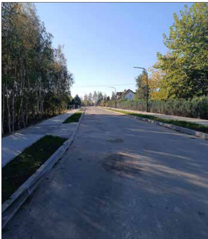
Drogi – osiedle Broniewek
