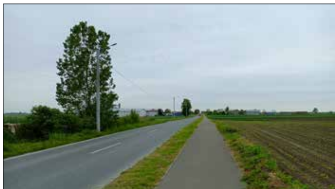
Oświetlenie ścieżki pieszo-rowerowej wzdłuż drogi powiatowej Bronisław – Dobro
