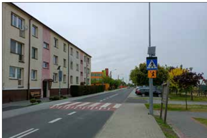
Przebudowana ul. Szkolna w Dobro
