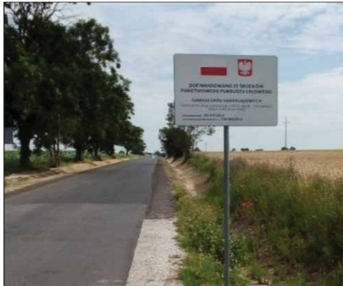
Przebudowa drogi powiatowej nr 2837C Skuły – Tomisławice w roku 2020
