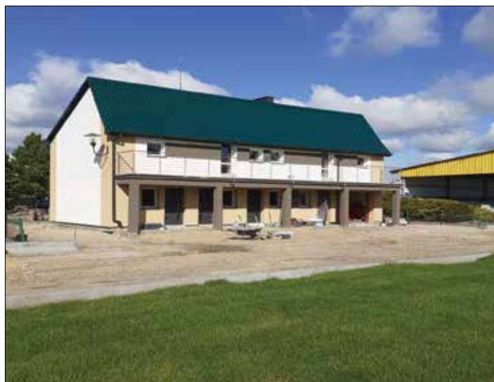
Budynek socjalny w czasie remontu
