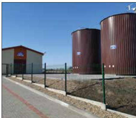
Przebudowana stacja uzdatniania wody
