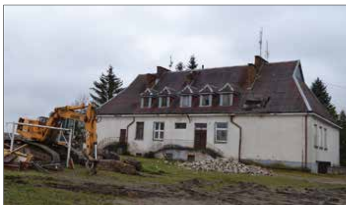
Roboty budowlane na terenie byłej Szkoły Podstawowej w Znaniewie
