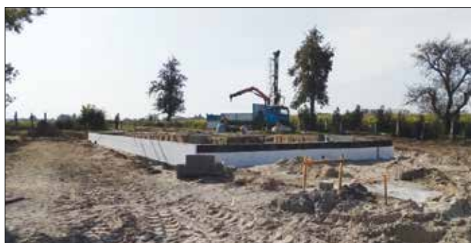
Roboty budowlane przy nowym budynku stacji
