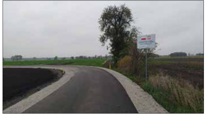
Zmodernizowany odcinek drogi Dobre Wieś – Buczyna Kolonia
