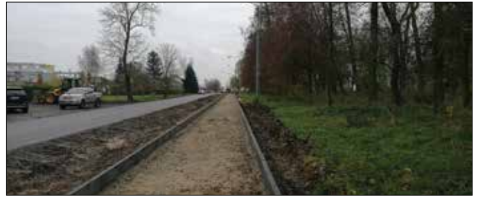
Budowa ścieżki w Płowcach
