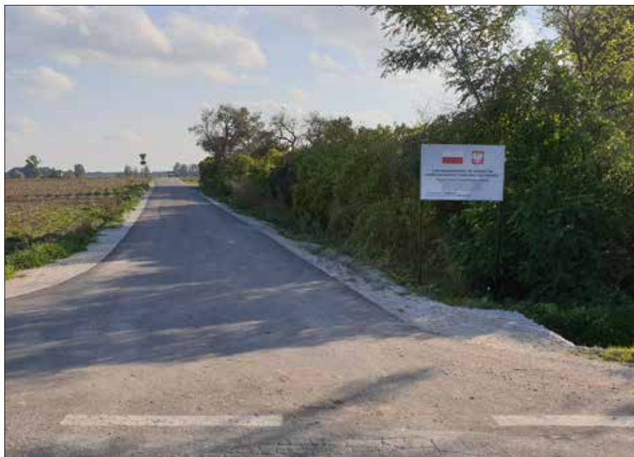
Ukończony w drugim etapie prac remontowych odcinek drogi gminnej Świesz-Czarnotka
